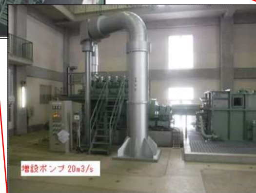
▲手城川排水機場ポンプ設置状況
